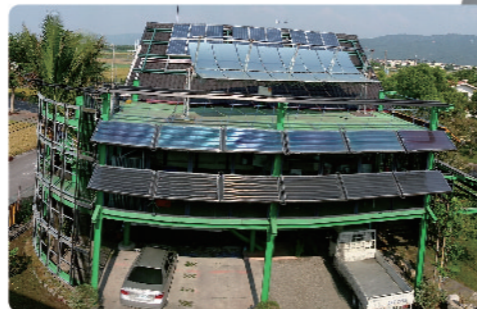
PVT雙效光電模組 (光電板+熱水回收系統)
